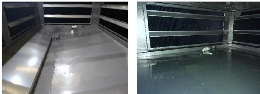
**6° PASO:** después de la inicialización del condensador, observe si la dirección de la distribución del agua ocurre en el sentido del centro de la bandeja, en la posición "v". Cierre las ventanas de inspección y libere el equipo para su uso.
