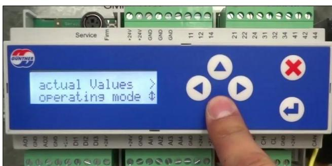
**3° PASSO:** quando localizar o submenu setpoint pressione a seta duas vezes para a direita
