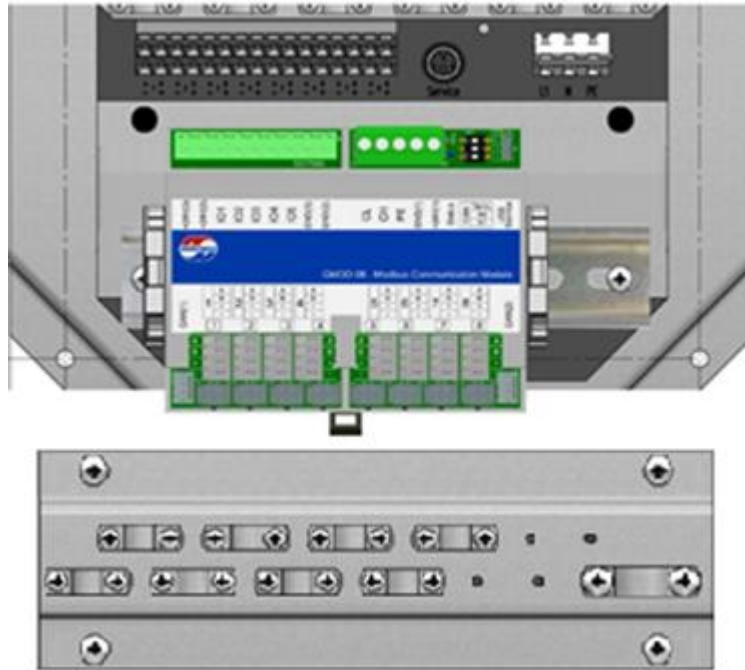
Figura 13: Fixação de barra de proteção.
