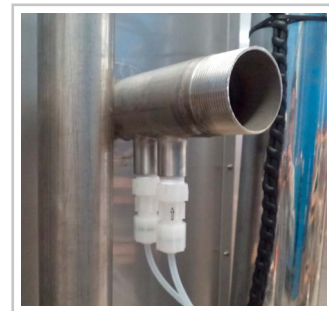
10: Nipples do tratamento de água
