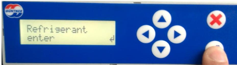
8B) Controle por pressão seleccione "Bar", por temperatura seleccione o fluido
