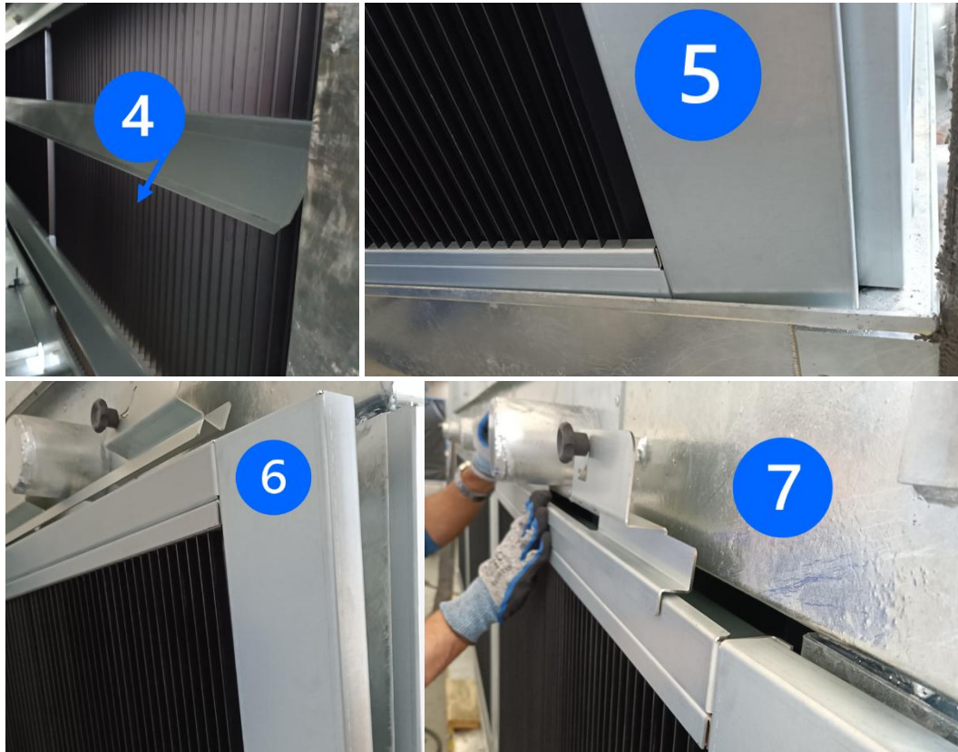
Figure 20 - Montaje de las rejillas.
