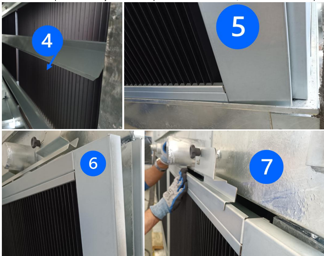
Figura 21 – Montagem das grades.
