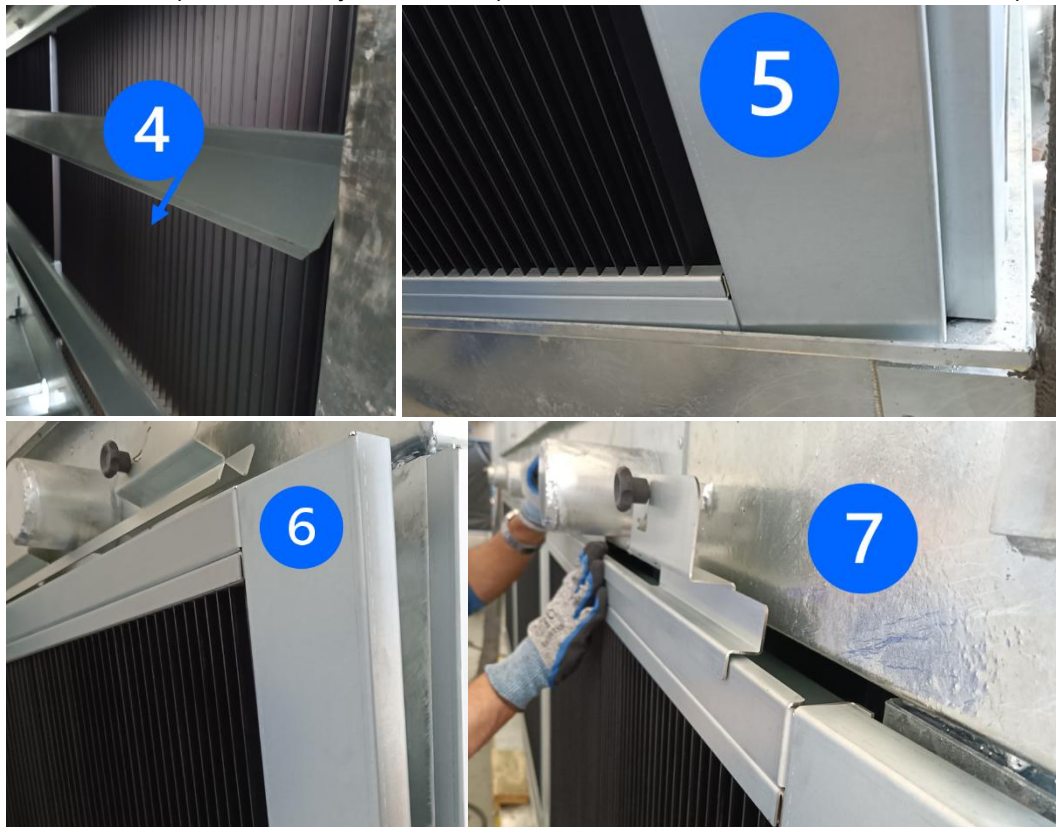
Figura 11 – Montagem das grades.
