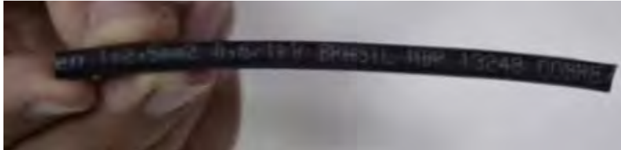
Figura 1 – Identificação de cabos
