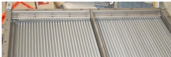
Depois da montagem (ou religação), proceda à limpeza das serpentinas de permuta de calor (de lamelas).
