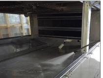
3° PASSO: retire o filtro da sucção da bomba, realize a limpeza e reposicione.
